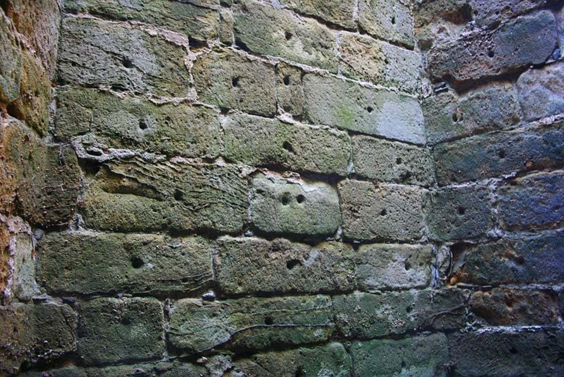
Mauerwerk aus der Zeit des Klosterbaus
