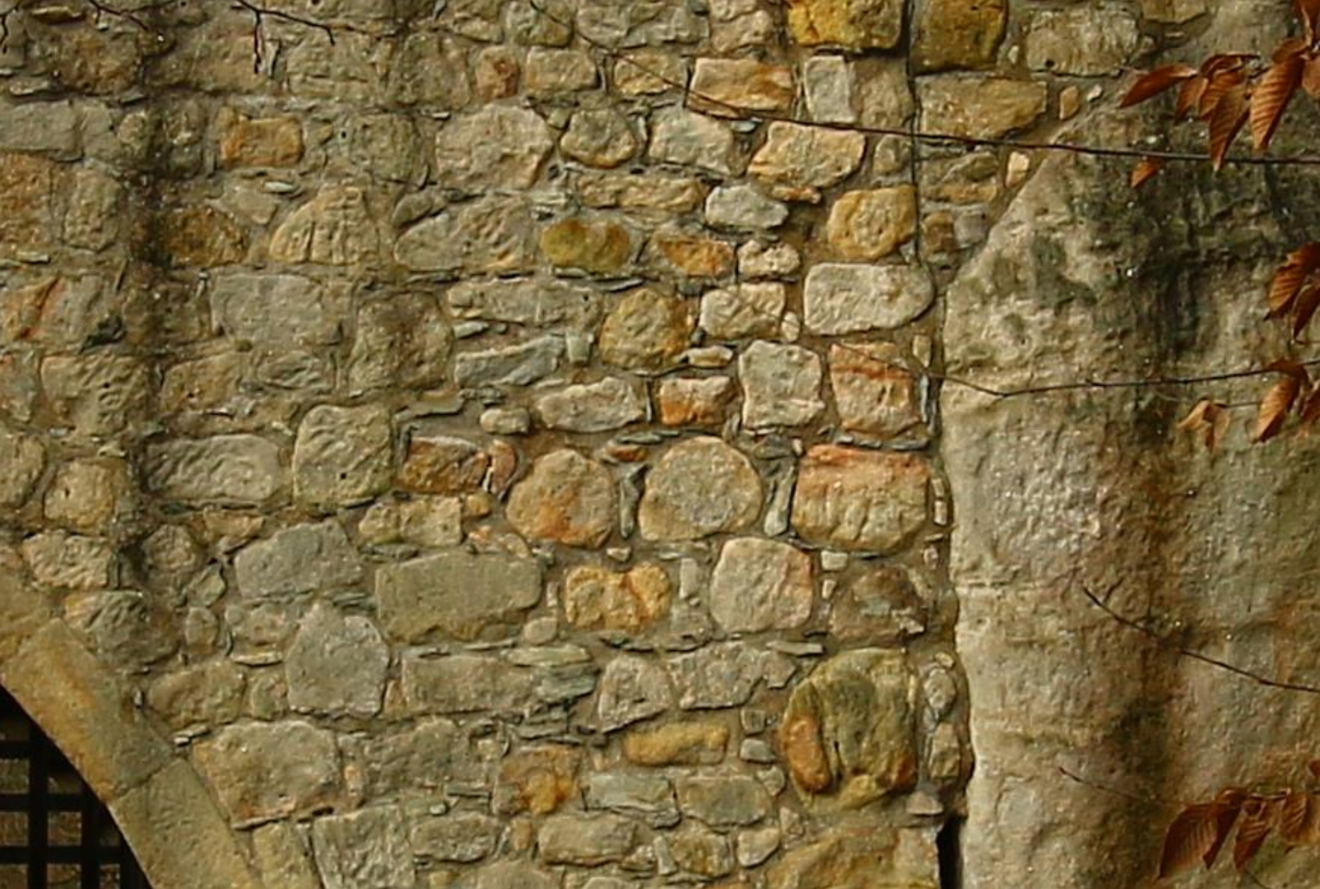
Mauerwerk aus der Zeit der Leipa-Burg
